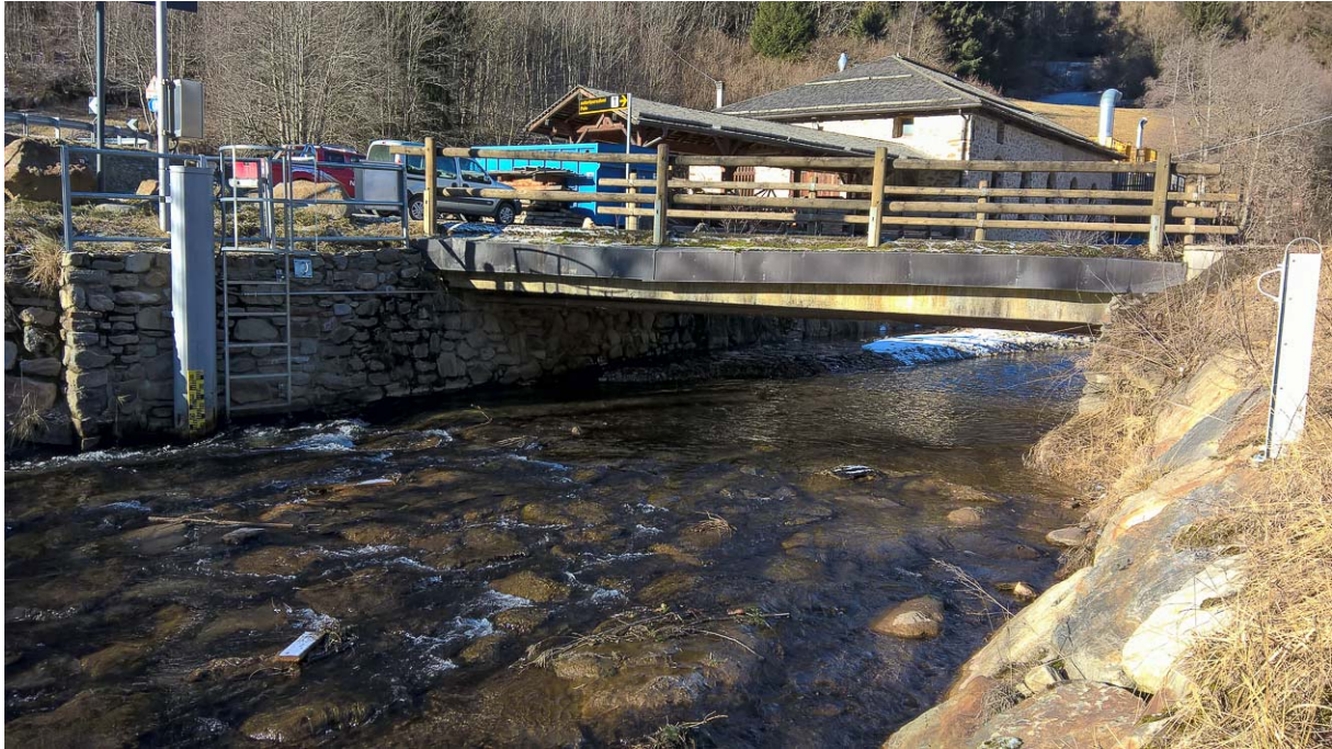
Figura 8 – Vista da valle della stazione idrometrica S2 – Cogolo in data 15 gennaio 2019 in condizioni di magra, posizionata sulla platea in massi fuggati di circa 8,4 m di larghezza, in cui è stata ricavata la canaletta di magra (0,65 m di larghezza in destra orografica), per circa 13 m di sviluppo lineare a partire dal lato di valle del ponte carrabile.
