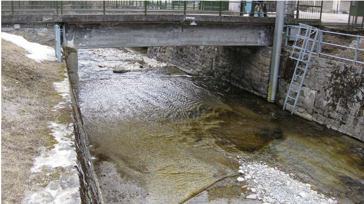
Figura 4 – Vista da monte della stazione idrometrica S1 – Pont in data 13 marzo 2019 in condizioni di magra, con la platea in cemento di circa 8 m di larghezza, in cui è stata ricavata la canaletta di magra in destra orografica (per 1,45 m di larghezza a partire dal muro), avente lo sviluppo lineare di circa 12 m a partire dalla soglia sotto il lato di valle del ponte carrabile. Al centro del canale si nota il deposito di ghiaie e ciottoli che lambiscono la platea, come risultante del processo di accumulo e deposito che avviene nel tratto a monte.
