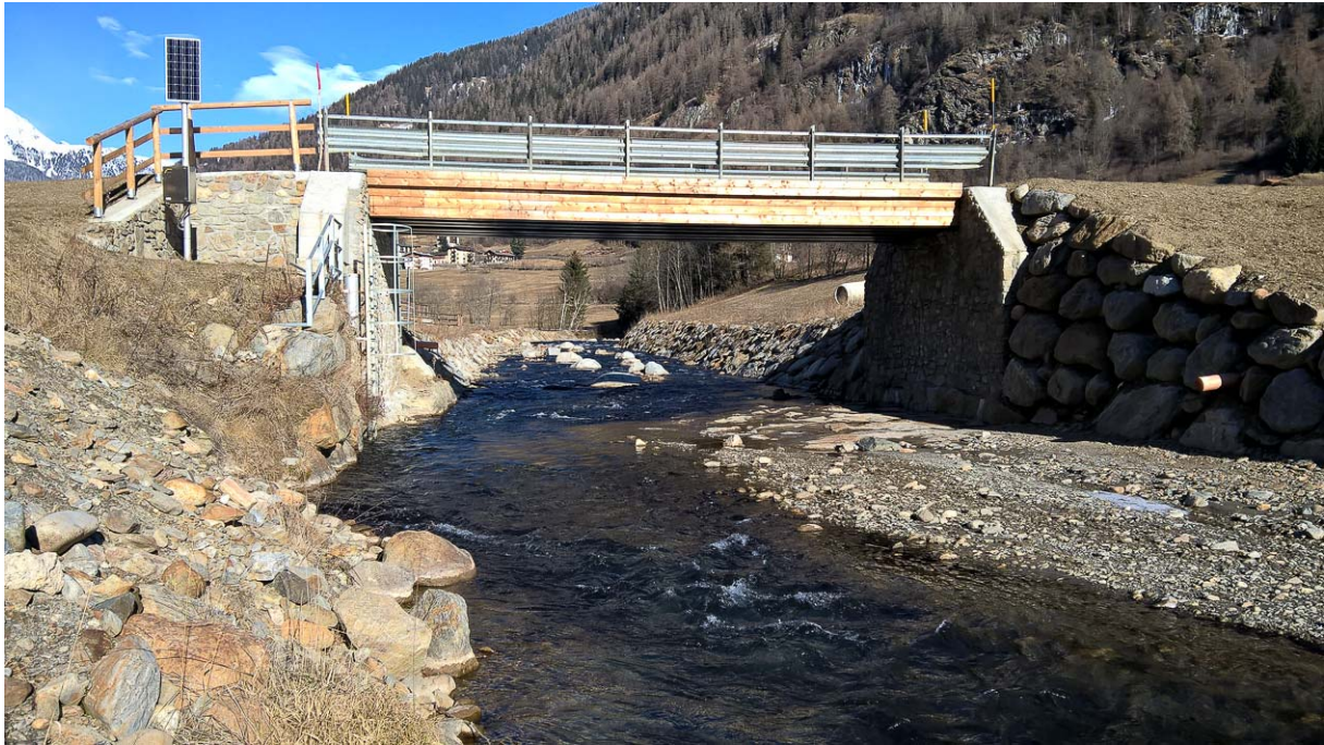
Figura 12 – Vista da valle della stazione idrometrica S3 – Contra in data 15 gennaio 2019 in condizioni di magra, posizionata sulla platea in massi fuggati di circa 12,3 m di larghezza, in cui è stata ricavata la canaletta di magra (2,9 m di larghezza in destra orografica), per circa 11 m di sviluppo lineare a partire dal lato di monte del ponte carrabile.
