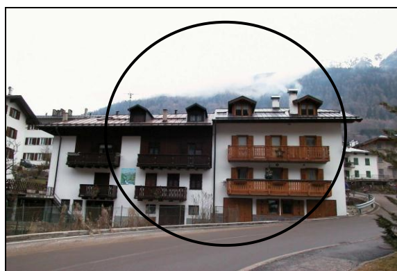
Intervento a Cogolo
