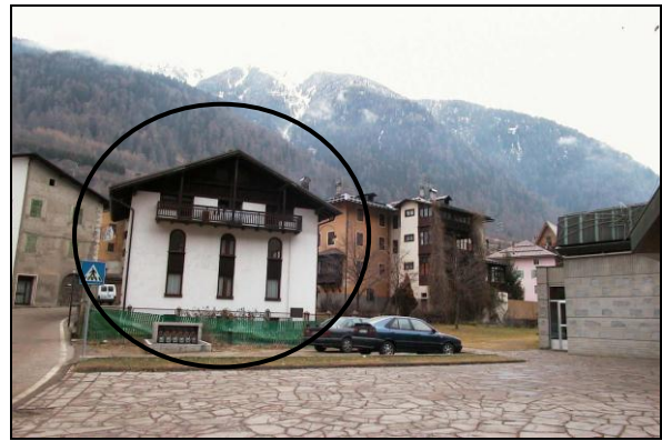
Intervento a Cogolo
