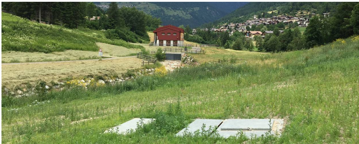
Fig. 28 - Stazione C1 - Impianto di Contra, vista da Sud e dalla sponda opposta (sinistra) del T. Noce durante un controllo delle stazioni in data 20.07.2021: in primo piano le botole di accesso alle vasche di presa interrata dell'impianto sottostante (C2 – Castra) e al centro dell'immagine le griglie e la platea dello scarico di emergenza della centrale di Contra, appena soprastante.
