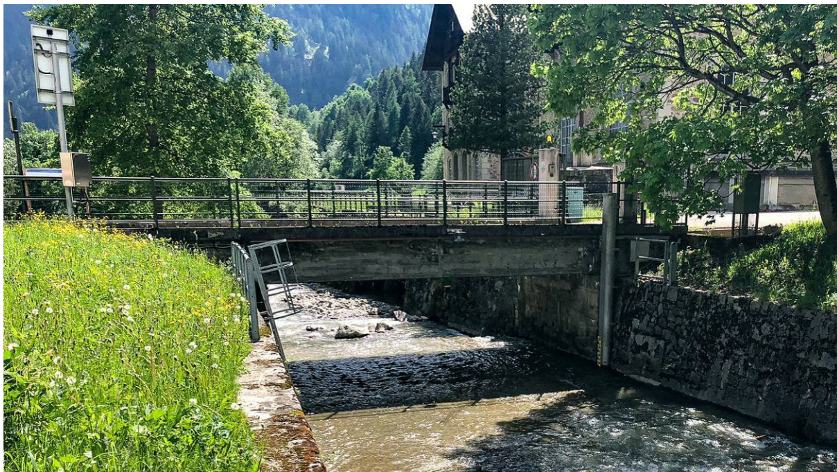
Fig. 22 - Infrastrutturazione della stazione di rilevamento S1 in data 27.05.2022 durante un intervento di manutenzione e controllo ordinario, con la nuova posizione della scala di accesso e delle barriere protettive.
