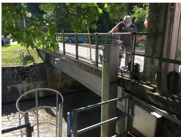
Fig. 2 - Manutenzione straordinaria della stazione S1 - Pont, eseguita in data 24.06.2020: 1) estrazione del carrello porta sonde dal tubo protettivo mediante catena, 2) immersione del turbidimetro nel liquido di controllo a torbidità nota per la verifica della corretta taratura.
