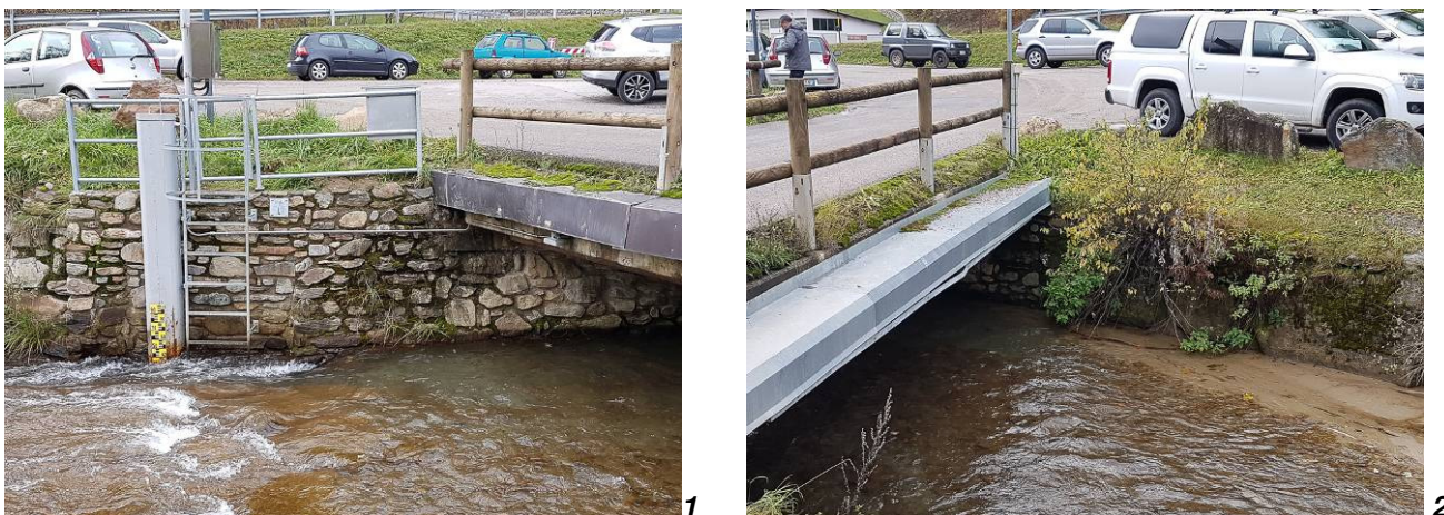
Fig. 3 - Manutenzione straordinaria della stazione S2 - Val del Monte, eseguita in data 30.10.2019, mediante: 1) posizionamento definitivo della sonda RLS (radar) a valle del ponte, 2) in sostituzione della posizione a monte, alterata dall'innalzamento della barra, a volte anche fuori acqua.
