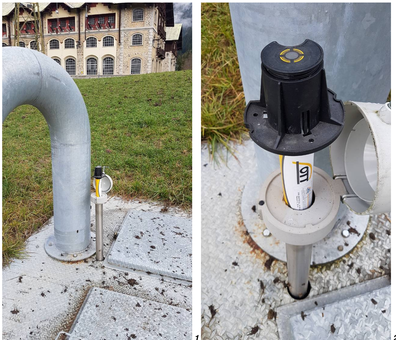
Fig. 5 - Manutenzione della stazione C0 - Pont, eseguita in data 30.10.2019, mediante 1) rimozione del cappello e 2) estrazione della sonda di livello e temperatura all'interno della vasca di carico.
