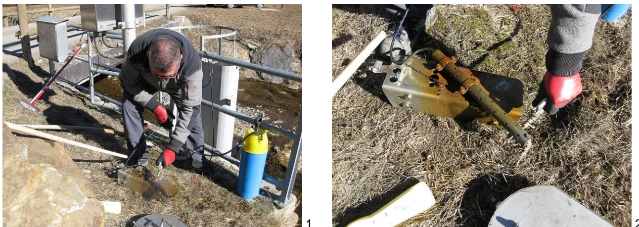
Fig. 2 - Manutenzione straordinaria della stazione S2 - Cogolo - Val del Monte, eseguita in data 14.03.2019, mediante: 1) estrazione del carrello dal tubo porta-sonde, 2) pulizia con getto d'acqua della sonda di livello.
