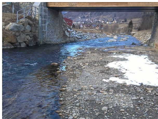
Fig. 30 - Stazione C1 - Impianto di Contra da valle durante la manutenzione delle stazioni il 29.01.2019: 1) edificio centrale e affianco l'alveo del T. Noce, nel tratto a valle del punto di scarico, dopo la conclusione dei lavori di sistemazione dell'alveo; 2) tratto a valle del ponte non sistemato.
