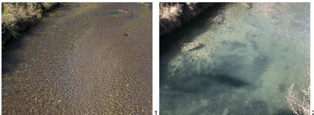
Fig. 2 - Pulizia straordinaria della sezione S2 - Cogolo, eseguita in data 31.10.2017, mediante rimozione di circa 92 m 3 dei sedimenti fini, sabbie e ghiaie, a monte del ponte e sotto l'impalcato (1 - prima dell'intervento, 2 - dopo l'intervento).
