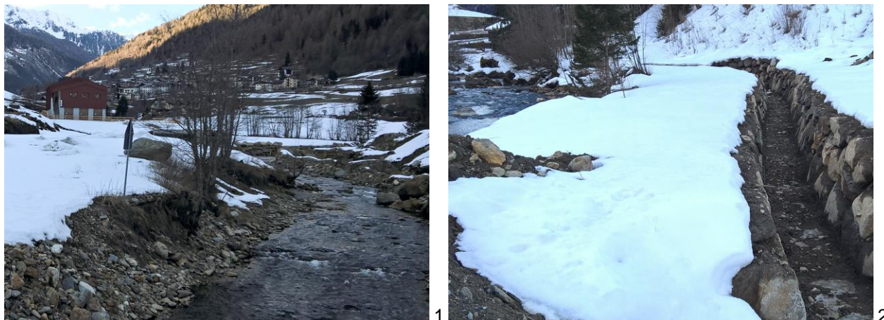
Fig. 33 - Stazione C1 - Impianto di Contra visto da valle durante la manutenzione delle stazioni in data 14.03.2018: 1) edificio centrale e affianco l'alveo del T. Noce, nel tratto a valle del punto di scarico, prima della conclusione dei lavori di sistemazione dell'alveo; 2) lavori di completamento dell'edificio centrale, particolare dei drenaggi che confluiscono nel T. Noce a valle del ponte.
