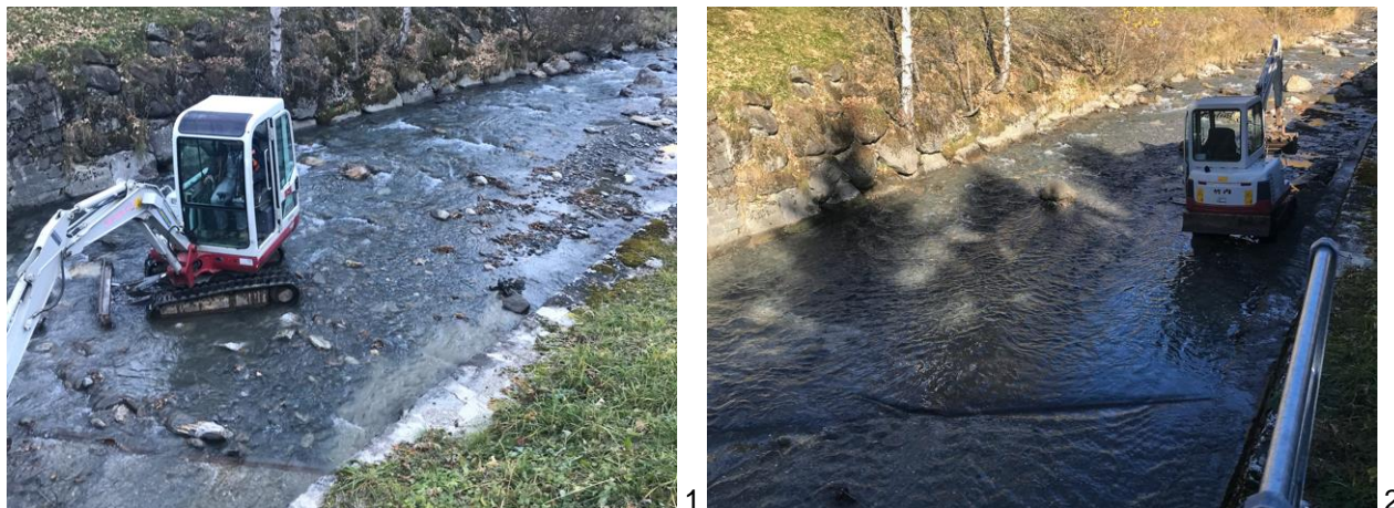
Fig. 1 - Pulizia straordinaria della sezione S1 - Pont, eseguita in data 30.10.2017, mediante rimozione a monte del ponte e della platea in cls di circa 30 m 3 di ghiaie, ciottoli e piccoli massi (1 - prima dell'intervento, 2 - dopo l'intervento).
