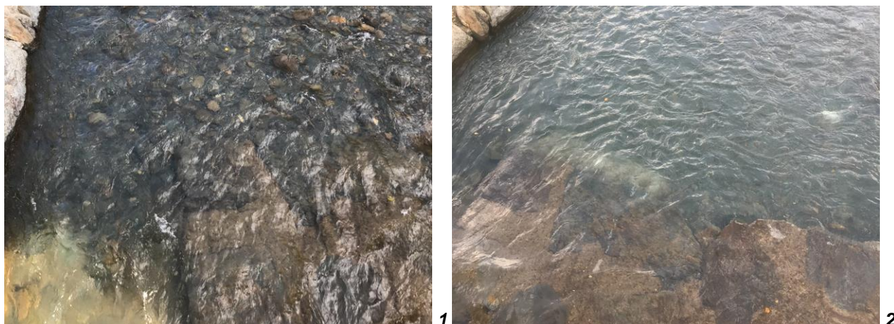
Fig. 3 - Pulizia straordinaria della sezione S3 - Contra, eseguita in data 27.10.2017, mediante rimozione attorno alla stazione di circa 110 m 3 di ciottoli e piccoli massi (1 - prima dell'intervento, 2 - dopo l'intervento).
