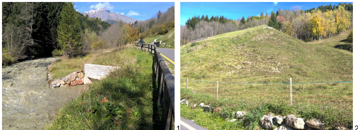
Fig. 34 - Stazione C2 - Impianto di Castra durante l'evento di svasso del bacino di Malga Mare in data 09.10.2017: 1) scarico in alveo della centrale di Castra, 2) prospetto da valle degli edifici interrati, in particolare opere di presa dell'impianto di Cusiano, al primo livello interrato, e sovrastante edificio centrale dell'impianto di Castra, al secondo livello dell'edificio interrato.
