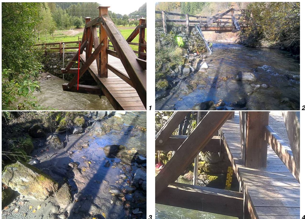
Fig. 5 - Stazione S4 in data 19.08.2015: 1) in evidenza la necessaria ricollocazione del tubo proteggi sensore al fine di evitare l'interrimento della sonda, e in data 05.11.2015 durante le fasi di finitura: 2) vista da valle durante l'installazione della sonda PLS in posizione definitiva, 3) evidenza dei depositi spondali limosi a seguito della pulizia del bacino di Malga Mare durante il mese precedente, 4) asta idrometrica fissata sotto la spalla destra del ponte in legno di accesso alla centrale di Cusiano.
