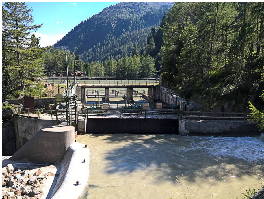
Fig. 153 - Immagine delle opere di presa di Malga Mare alla data del 20.07.2016 in condizioni di morbida estiva, con in primo piano la griglia di presa laterale, al centro i tre canali Dufour e sullo sfondo il bacino di Malga Mare.
