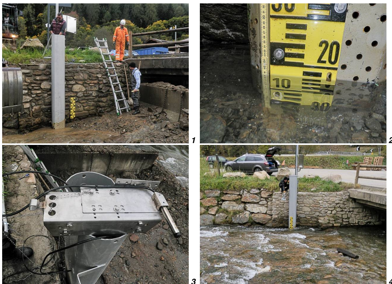
Fig. 2 - Installazione e finitura della stazione S2 eseguite in data 08.10.2015: 1) realizzazione della tura in alveo per il settaggio definitivo della stazione; 2) installazione dell'asta idrometrica sul tubo di protezione della sonda e verifica delle quote rispetto al fondo della canaletta di magra; 3) installazione del carrello definitivo per il sostegno della sonda PLS; 4) installazione del palo porta sonda radar RLS (nell'immagine di data 28.10.2015 fase successiva di regolazione della sonda).
