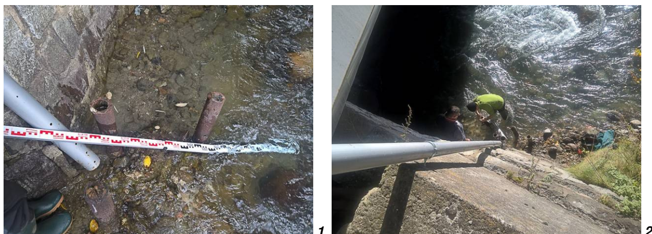
Fig. 6 - Stazione S5: 1) in data 28.10.2015 verifica delle dimensioni del pezzo curvo finale del tubo di alloggiamento della sonda PLS da ancorare agli spezzoni dei tubi alla base del ponte di Ossana, 2) in data 05.11.2015 installazione del pezzo speciale e inserimento della sonda PLS con avvio delle registrazioni.
