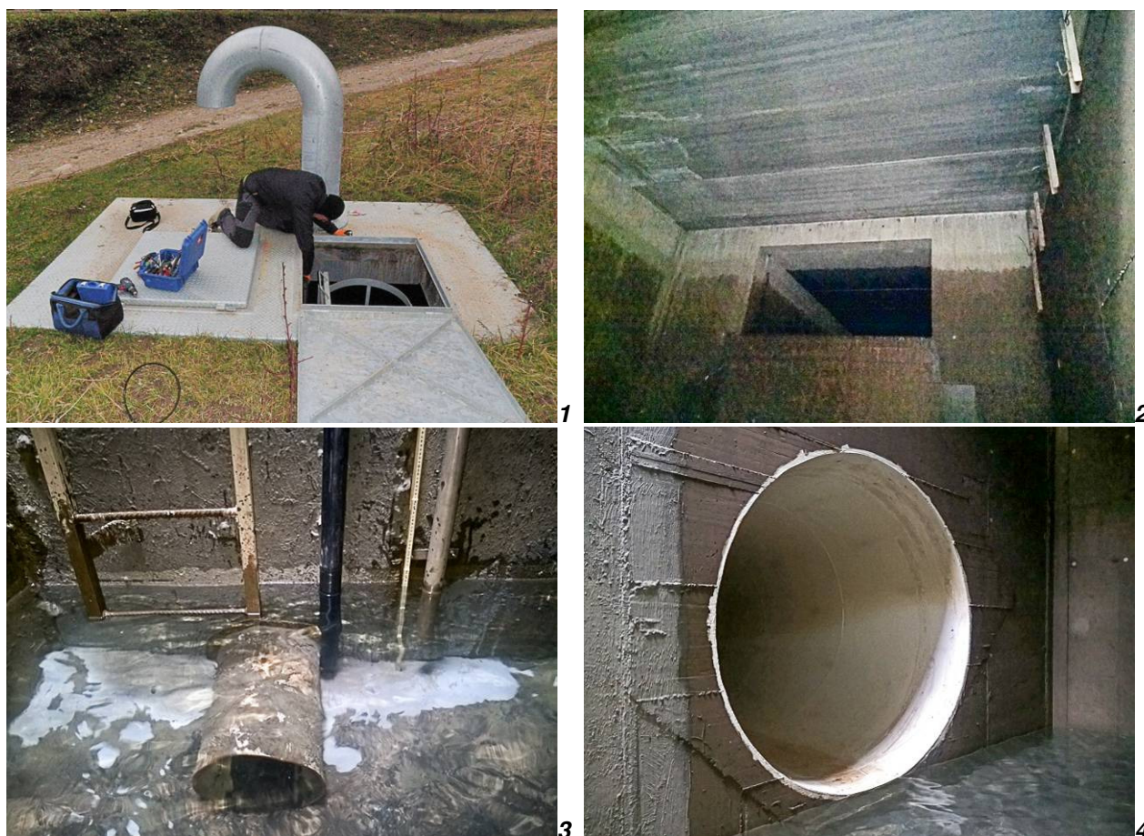
Fig. 7 - Stazione di rilevamento C0, interna alla vasca di presa dell'impianto di Contra, durante le fasi d'installazione della sonda di temperatura e livello, in particolare: 1) in data 28.10.2015 il tombino di accesso alla vasca e la sistemazione dell'antenna di trasmissione dei dati posta a fianco del fungo di sfiato e aerazione; successivamente in data 01.12.2015: 2) immagine della bocca di alimentazione proveniente dal canale di scarico HDE; 3) fissaggio della prolunga di tubo nero di alloggiamento della sonda a lato dello scarico di fondo (con sonda sotto il livello dell'acqua in vasca a impianti fermi); 4) testa della condotta DN2200 con fondo tubo (livello acqua) posto a 56 cm dal pavimento della vasca.
