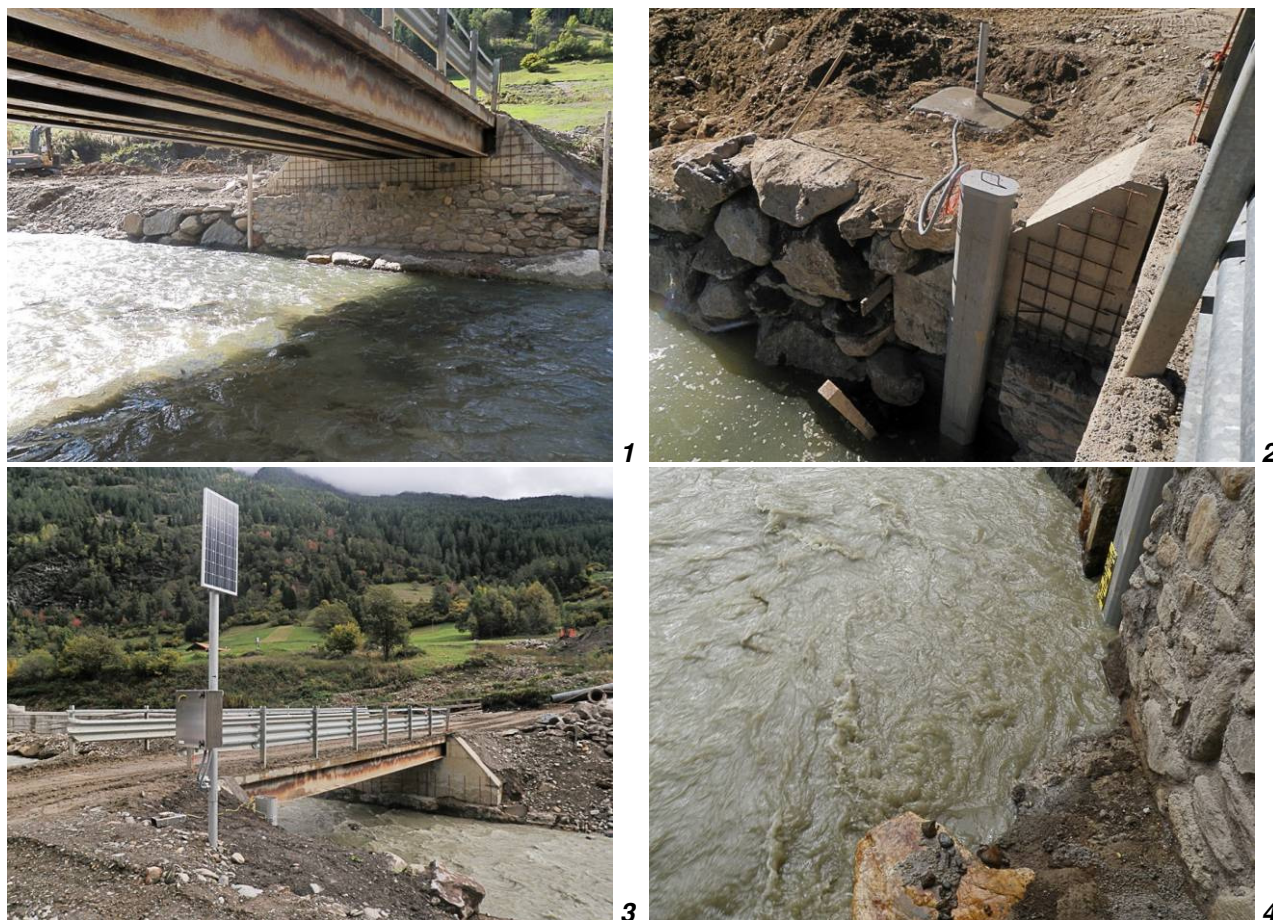
Fig. 3 - 1) Stato del ponte di cantiere in loc. Masi di Contra alla data del 25.09.2015 (notare la scogliera residua alla base della spalla rivestita del ponte), 2) installazione in verticale del tubo di protezione in una nicchia del rivestimento con predisposizione della fondazione del palo in alto, effettuata in data 29.09.2016, 3) pannello fotovoltaico e cassetta inox/datalogger installate sul palo in data 02.10.2015, 4) evidenza dell'influsso della scogliera residua (1 m di sporgenza) alla base del muro (sezione definitiva) sulla direzione della corrente all'interno della canaletta di magra, in data 08.10.2015, durante le operazioni di primo settaggio della strumentazione.
