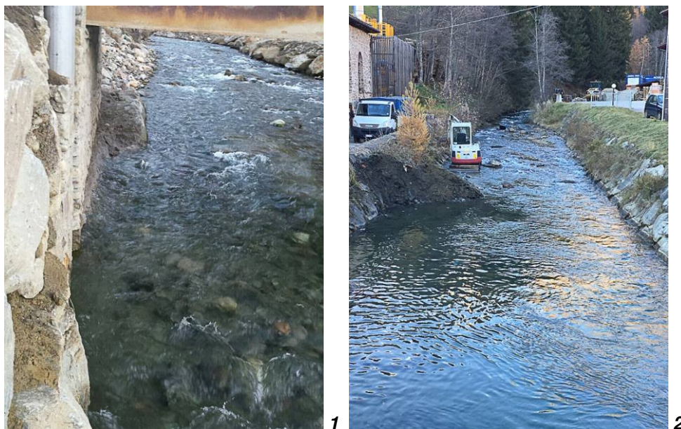
Fig. 4 - Interventi in alveo eseguiti dalla ditta Santini di: 1) eliminazione della scogliera residua alla base del ponte in S3 in data 19.10.2015, poi completati in data 09.11.2015 con l'asportazione dei sedimenti da monte a valle della platea in massi ciclopici cementati esistente sotto il ponte; 2) eliminazione dei sedimenti finì depositatisi a monte della stazione S2 e sotto il ponte in loc. Segheria eseguita in data 13.11.2015.
