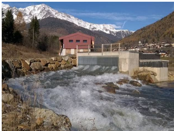
Fig. 23 - Stazione C1 - Impianto di Contra visto da valle durante i rilievi di portata eseguiti in data 15.11.2016: 1) scarico della massima portata turbinata (5.150 l/s) che si aggiunge alla portata fluente in alveo, 2) chiusura dello scarico con presenza in alveo di una portata di 1.180 l/s.
