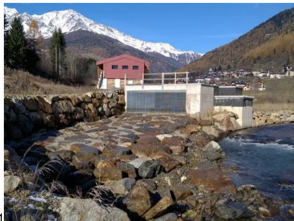
Fig. 23 - Stazione C1 - Impianto di Contra visto da valle durante i rilievi di portata eseguiti in data 15.11.2016: 1) scarico della massima portata turbinata (5.150 l/s) che si aggiunge alla portata fluente in alveo, 2) chiusura dello scarico con presenza in alveo di una portata di 1.180 l/s.
