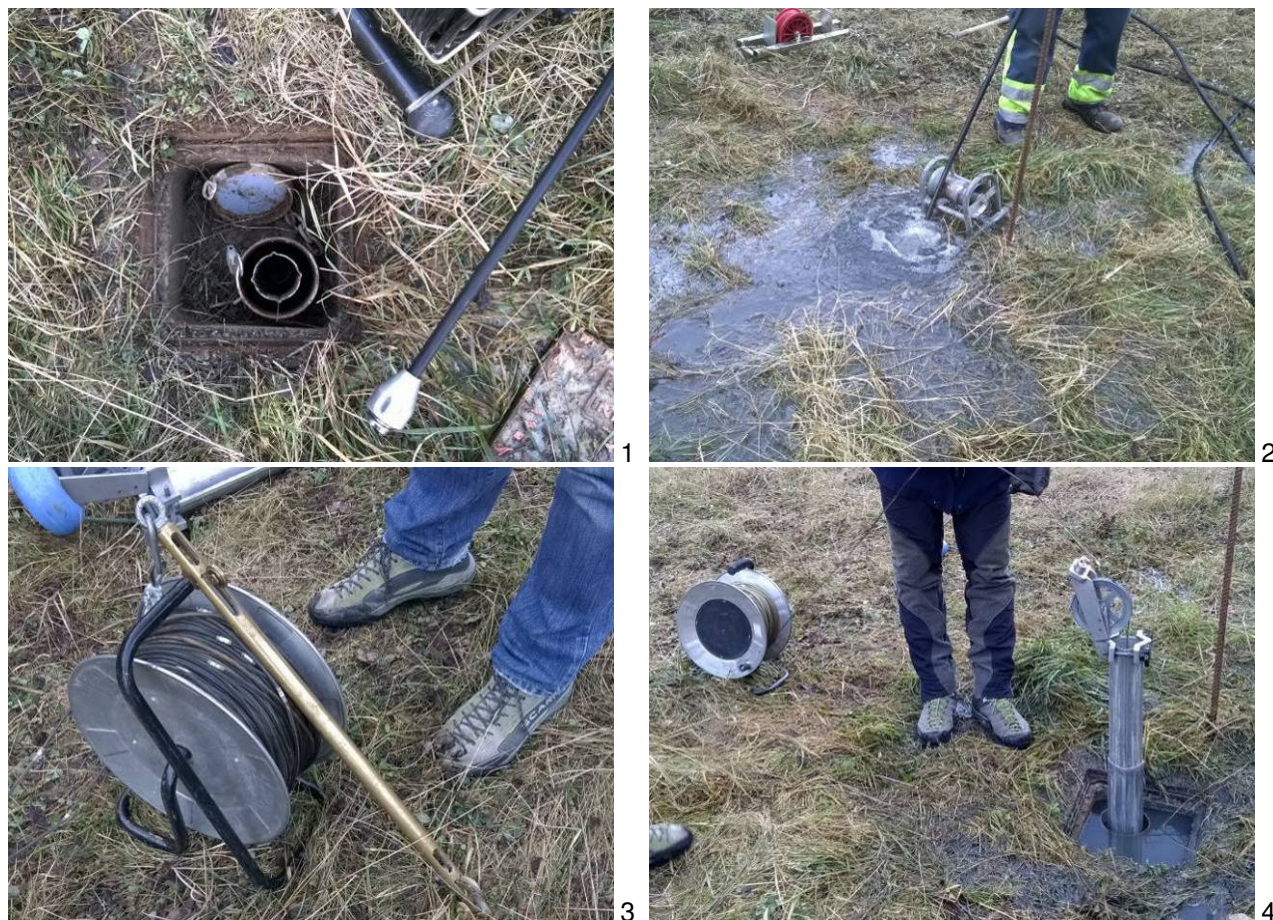
Fig. 7 - Manutenzione straordinaria del tubo P4 - Centrale di Castra eseguita in data 15.11.2016: 1) testa tubo al termine della video ispezione eseguita dalla ditta Bonora per conto del Comune di Peio, 2) fase di lavaggio del tubo mediante immissione di acqua in pressione, 3) sonda testimone, 4) verifica del tubo tramite sonda testimone.
